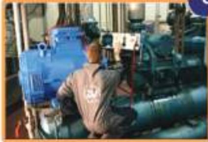
En générant une impulsion électrique, l'appareil à ondes de choc permet de visualiser un défaut même minime entre spires, entre bobines ou entre phase sans détruire le bobinage.
