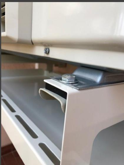
Bac de récupération des eaux de condensation. Finition parfaite, évite les pertes de condensation du groupe extérieur. Avec resistance, il permet l'évaporation des eaux ( bien utile lorsque aucune évacuation n'est disponible )
