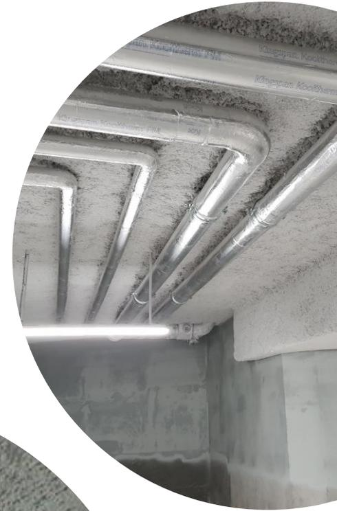
**flocage pâteux** : Pâteux à densité standard (base perlite, vermiculite, plâtre, etc.) Plâtre - Pâteux haute densité (base ciment) Le flocage pâteux permet de remplir les caractéristiques suivantes: Protection passive incendie - Correction acoustique - Traitement anti-condensation
