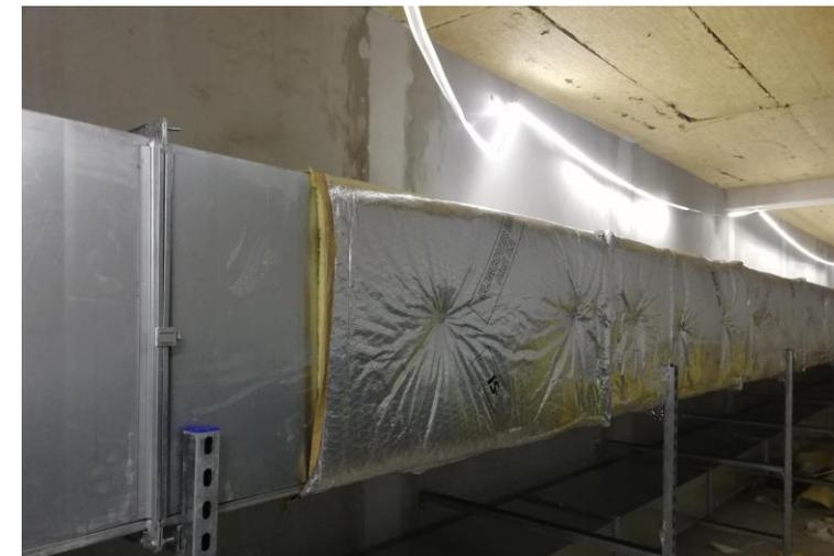
Le calorifuge de tout type d'équipement chaudière, climatisation, tuyauterie et accessoires de conduite, de fluides thermiques faisant appel à des matériaux et un savoir faire de spécialiste. Le calorifuge d'installations industrielles, de conduites de fluide thermique de très haute température, l'isolation de tuyauterie d'eau glacée à l'aide de matériaux spécifiques répondant aux contraintes techniques.
