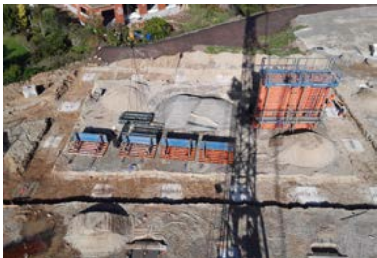
Démarrage du chantier, vu de la grue
