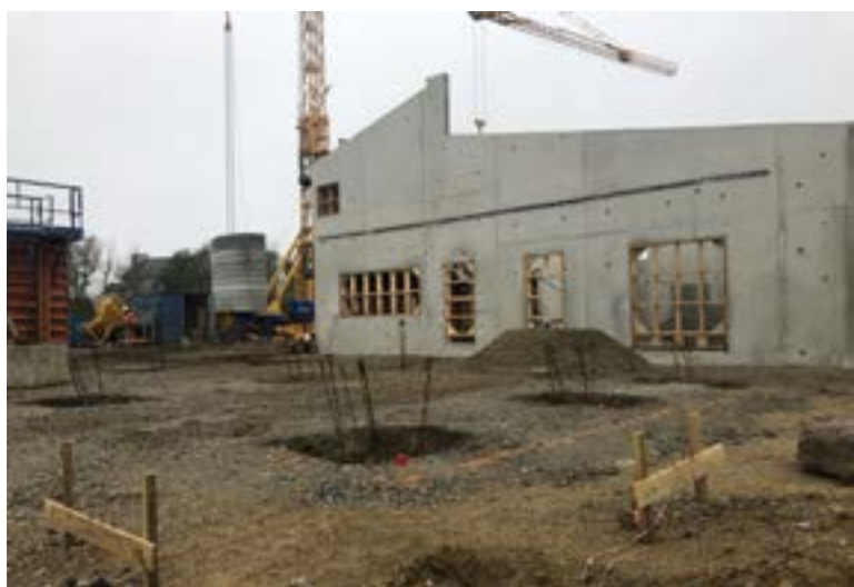
Fondations Élévation des murs en béton banché
