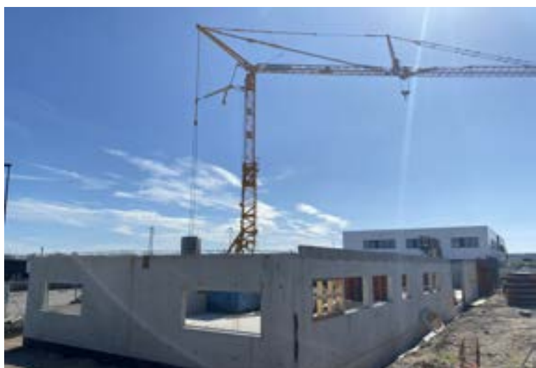
Élévation du rez de chaussé en béton banché
