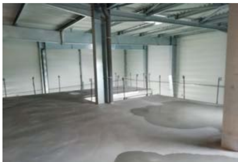
Coulage des chapes
