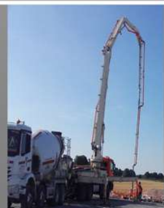
Pompe à béton
