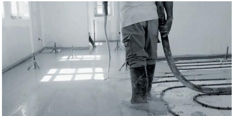
**Agilia CHAPE THERMIC A-5000 et A-5600 sont des chapes autonivelantes à base d'anhydrite, fibrées ou non, sans pellicule de surface. Leurs performances sont garanties par un DTA (Document Technique d'Application), délivré par la CCFAT.**
