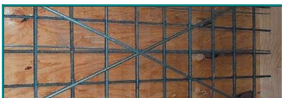
Avant coulage du béton
