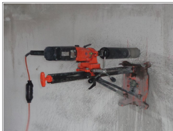
Carottage dans voile en béton armé
