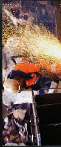
Evacuation déchets accès difficiles
