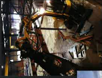
Intervention sur chantier
