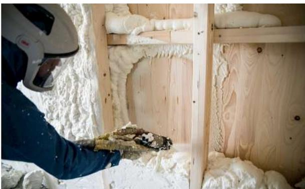
5° La mousse s'expande et colmate le moindre pont thermique (et phonique)
