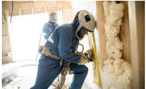
4° Projection brute (avec recoupe) ou au bouclier pour canaliser l'expansion de la mousse
