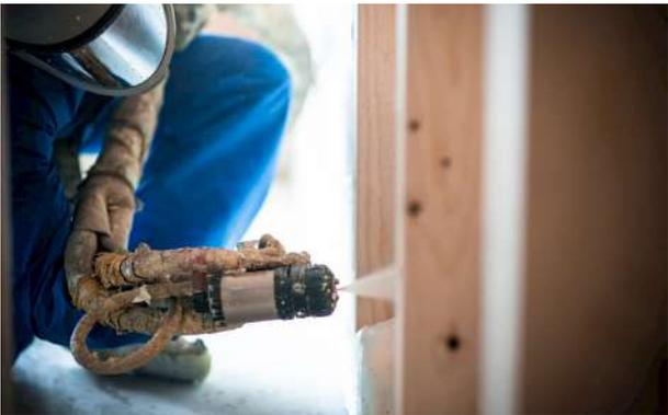
3° Projection de la mousse directement sur le support (sec et dépolvé) (sec et dépolvé)
